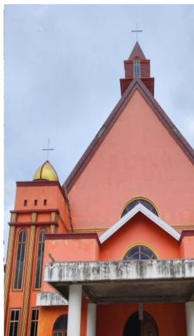
Gambar 1. Tampak depan bangunan gereja GKST Gloria, Desa Tangkura, Kecamatan Poso Pesisir Selatan, sesudah kejadian Gempa Poso 17 Agustus 2025.
